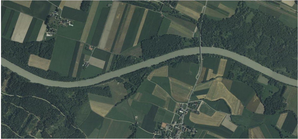
Foto 2.1: Im 19. Jahrhundert wurde der Flusslauf gestreckt und die Ufer gesichert.
